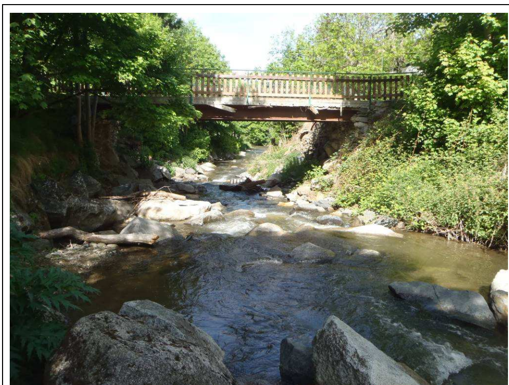
Photo 8 : station 4 - Aperçu général de la station ( Q=0.48 \text{ m}^3/\text{s} )
